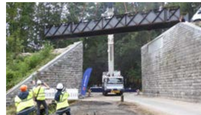
Pose de la passerelle
