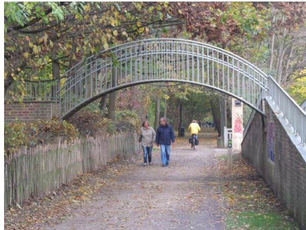
La Promenade du Chemin de Fer, ancienne ligne Bruxelles-Tervuren – La voie verte de la capitale de l'Europe
